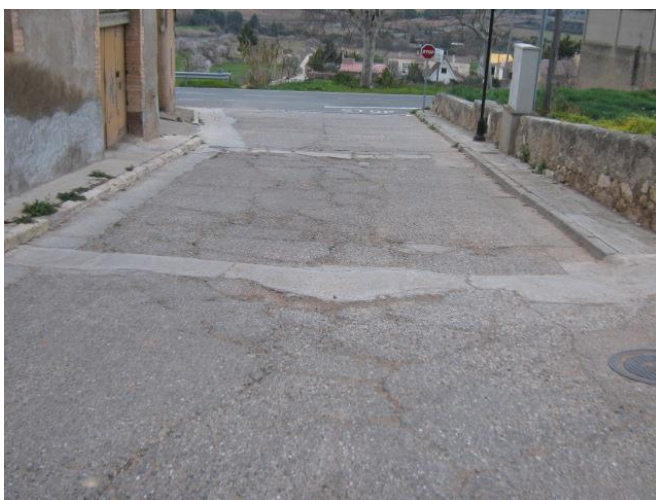
Arranjament carrer Costa d'en Francesc Barberà de la Conca Inici obres
