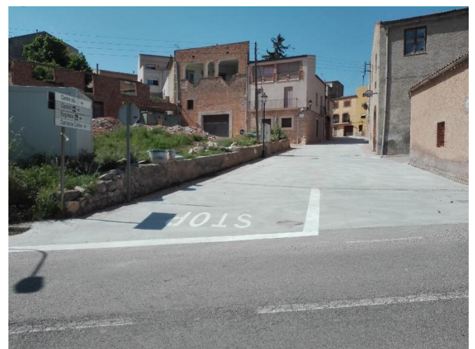
Estat final de l'actuació
