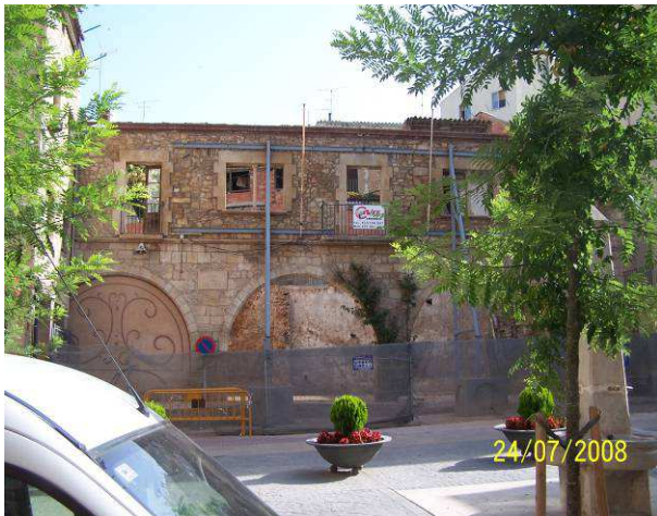
Ajuntament de Vimbodí i Poblet Inici rehabilitació
