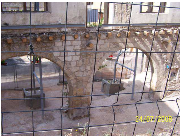
Ajuntament de Vimbodí i Poblet inici rehabilitació
