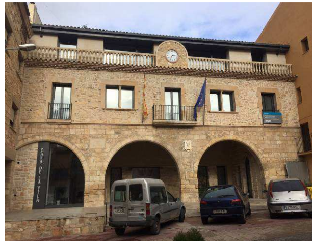
Estat final de la rehabilitació
