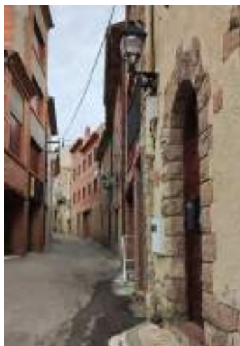
Enllumenat públic, Vilanova de Prades
