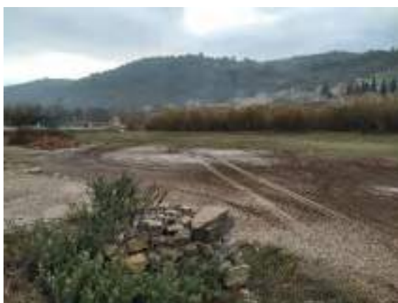
Rehabilitació espais urbans Vallfogona de Riucorb Inici obres
