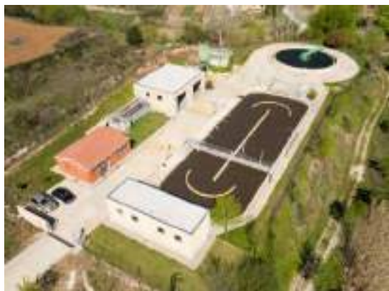
EDAR Espluga de Francolí
