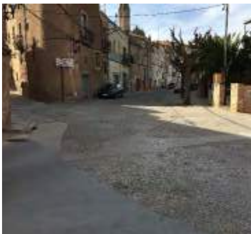
Raval del Castell Barberà de la Conca Inici obres
