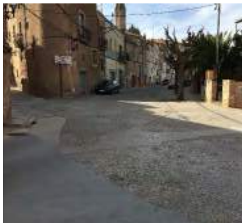
Raval del Castell Barberà de la Conca Inici obres
