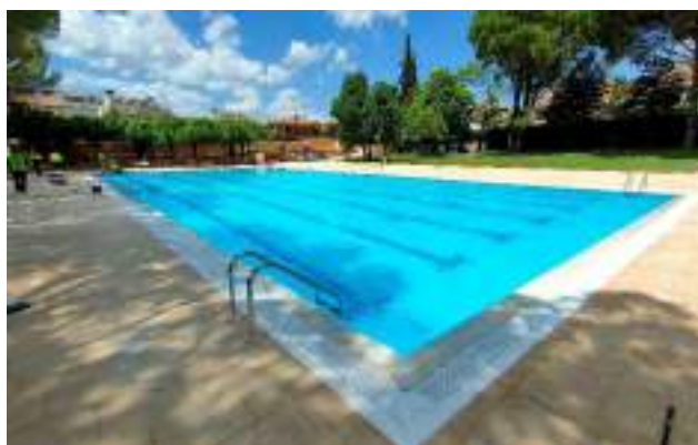
Estat final de l'actuació
