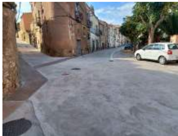
Estat final de l'actuació
