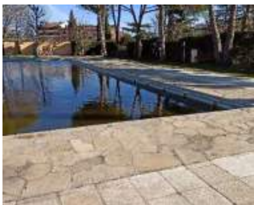
Adequació del vas i platja de la piscina municipal L'Espluga de Francolí Inici obres
