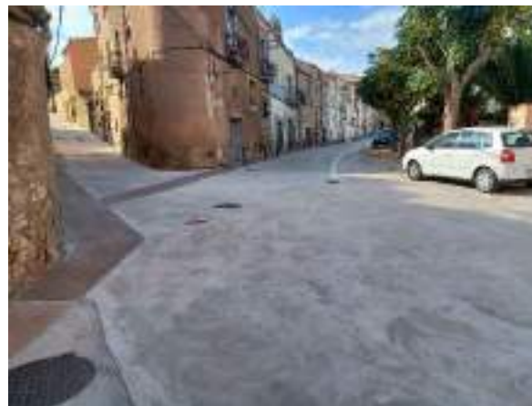
Estat final de l'actuació
