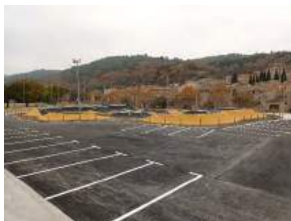
Estat final de l'actuació
