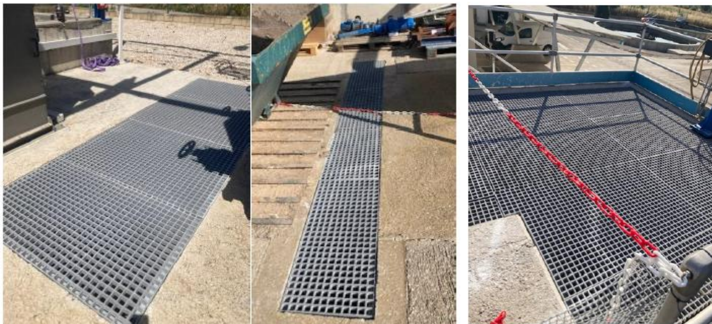
Substitució dels trànex de l'EDAR Montblanc
