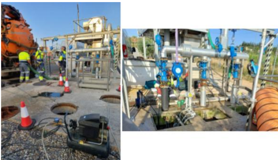
Treballs previs i col·locació de bancades i guies per les bombes del pou d'entrada de l'EDAR Solivella
