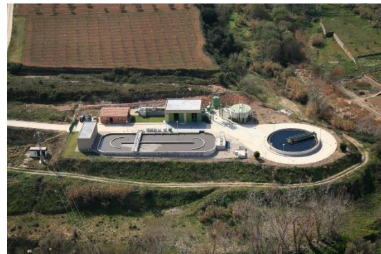
EDAR Espluga de Francolí
