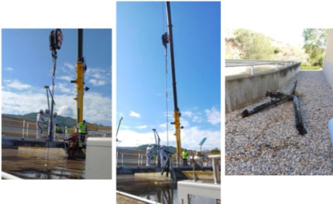
Treballs de busseig i canvi dels vehiculadors de l'EDAR de l'Espluga de Francolí
