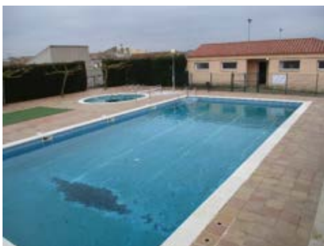
Adequació piscina municipal Conesa Inici obres
