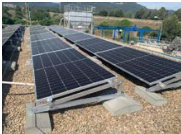
Instal·lació plaques fotovoltaiques EDAR Montblanc
