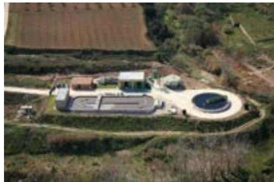
EDAR Espluga de Francolí
