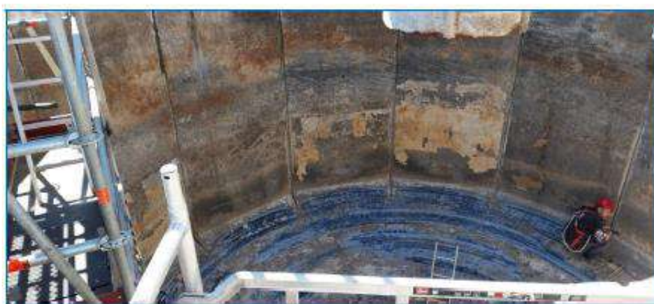
Reparació de l'espessor EDAR Montblanc
